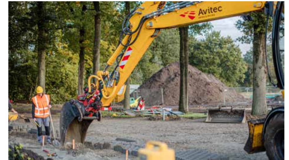
Uitvoering reconstructie door Avitec.
